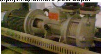
2 рабочих насоса производства фирмы WITT, оснащённых запорными вентилями на входе и выходе из насосов, обратным клапаном на выходе из насосов, фильтром – очистителем на входе насосов;
